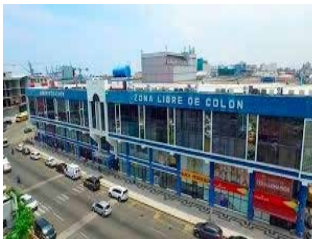
Figura 131 Vista del edificio de administración de la Zona Libre de Colón
