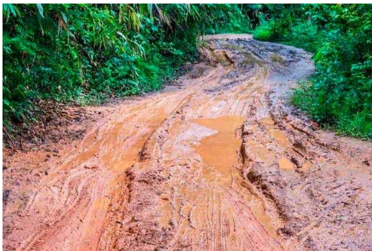
Figura 76 Condiciones de rutas de acceso en Costa Abajo de Colón, Año: 2022
