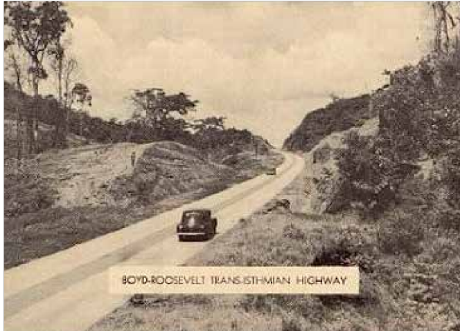
Figura 128 Construcción de la carretera Boyd–Roosevelt
