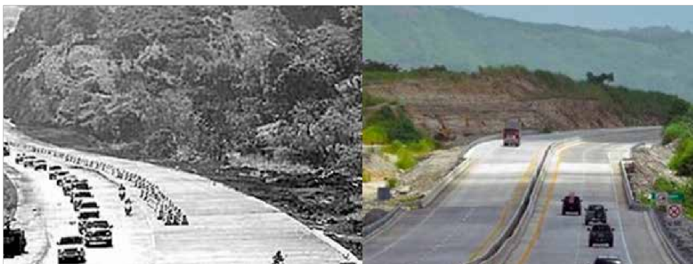
Figura 142 Primero y segundo tramo de la Autopista Panamá-Colón
