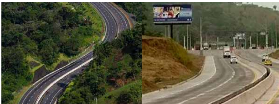
Figura 141 Autopista Alberto Motta Cardoze Corredores y Autopista Madden de ENA
