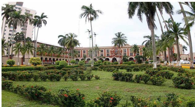
Figura 31 Vista del Hotel Washington
