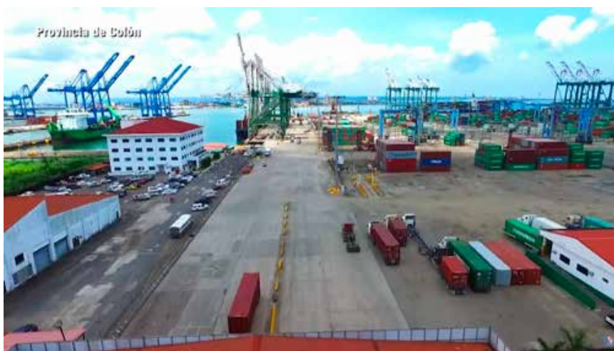
Figura 126 Puerto de Cristóbal
