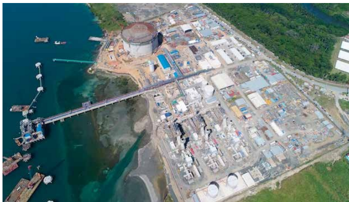
Figura 151 Vista panorámica AES-Colón
