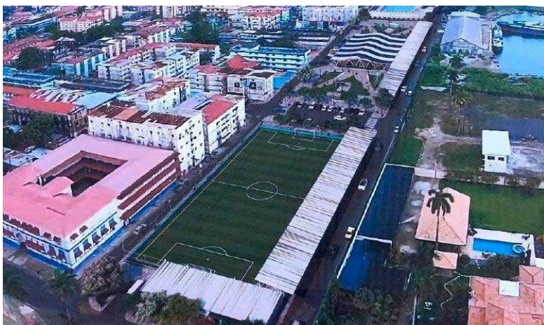
Figura 104 Centro Deportivo y Cultural en Barrio Norte
